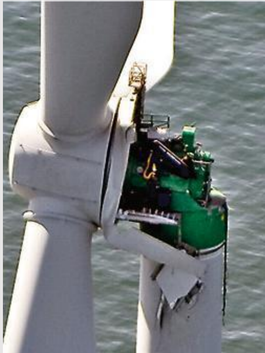
Beschädigte Gondel „alpha ventus“ (April 2018)
